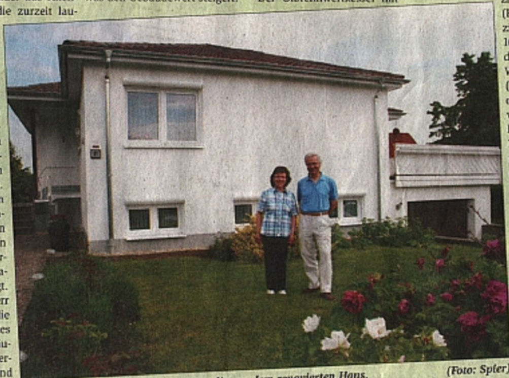
Wilhelm Binder mit seiner Frau Annelie vor dem renovierten Haus.
